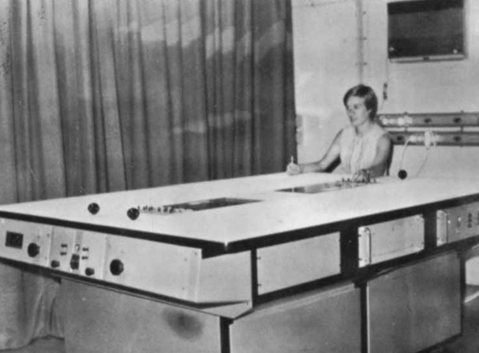
Εικόνα 3: Τραπεζι ανίχνευσης αντιδράσεων στοιχειωδών σωματιδίων (Πηγή: Πεπραγμένα 1967)
